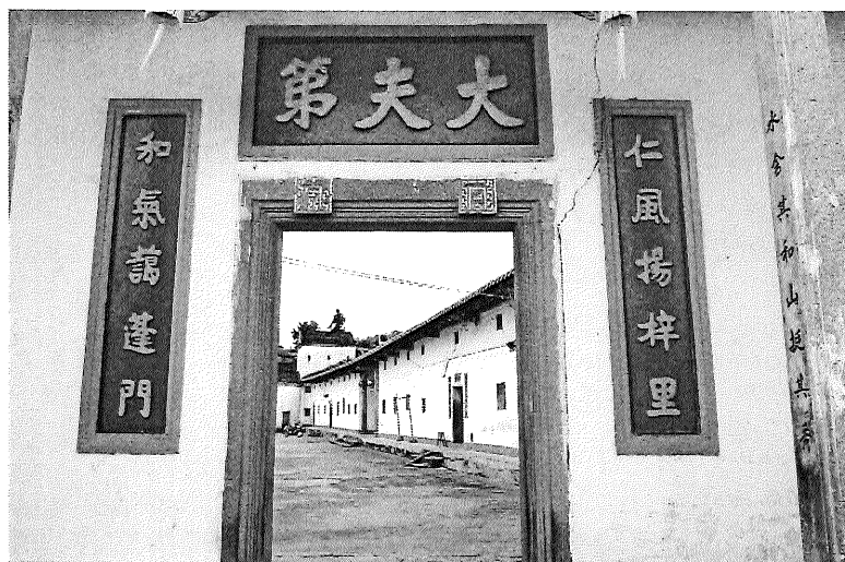
先祖父述初公營建的善述園，乃客家四角樓的代表作。
